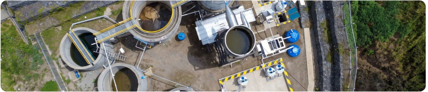
Planta de lixiviados con DTRO del GAD Santiago de Pillaro
