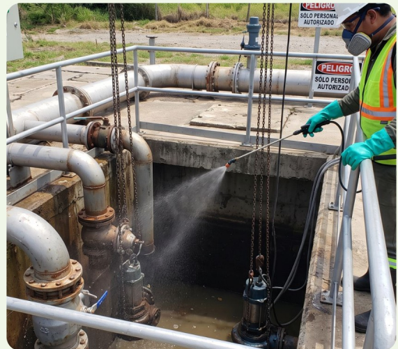
Aplicación en cárcamo de bombeo
