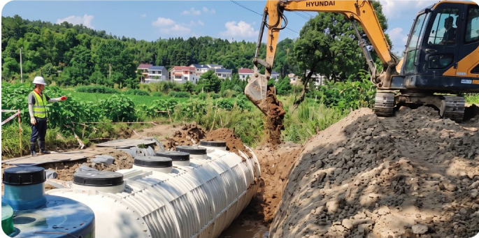
Instalación de una planta soterrada Johkasou
