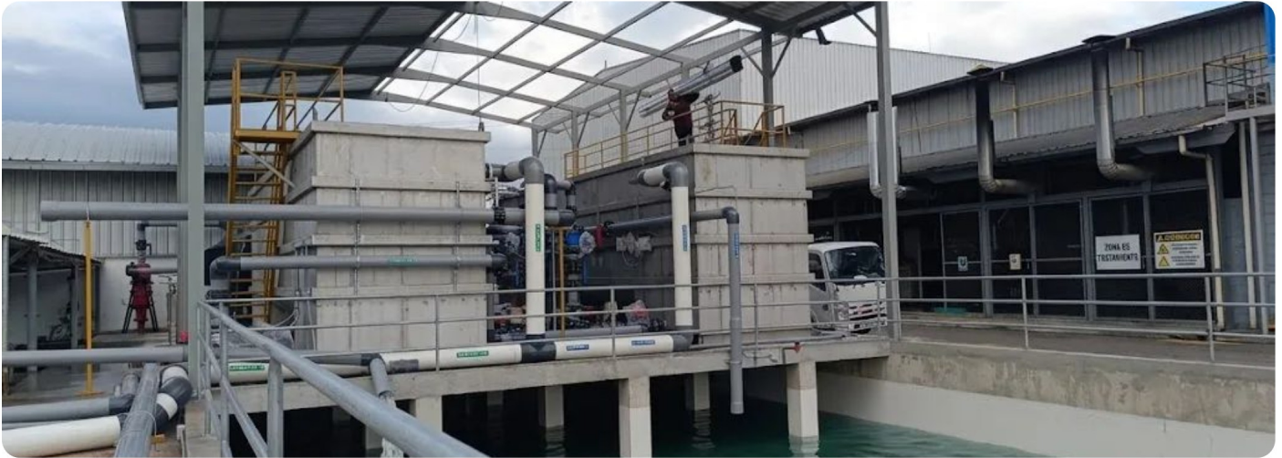
Planta de tratamiento de agua potable de Provefrut · 162 m 3 /h
